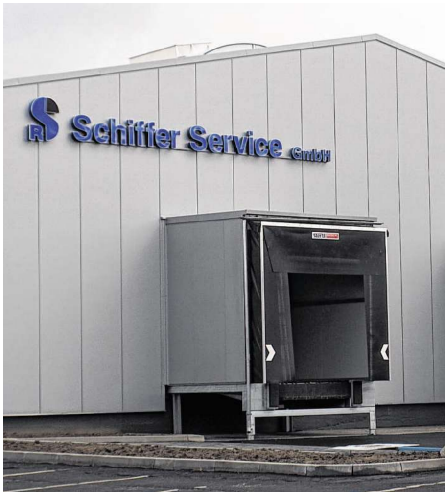
Bei der Sanierung der Lagerhalle wurde auf die speziellen Anforderungen eines Logistikers eingegangen.
